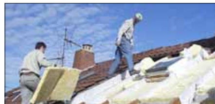
Wenn das Dach neu eingedeckt werden muss, ist es Zeit, die Dämmung zukunftsfähig zu machen. Spätestens jetzt muss sie den Anforderungen der Energieeinsparverordnung genügen. Hier: Zwischensparrendämmung aus Mineralwolle.
