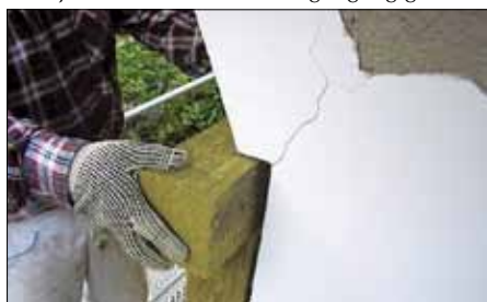
Es muss nicht immer Polystyrol sein: Hier dient Mineralwolle als Dämmstoff bei der Außenwanddämmung. Foto: VZ RLP
