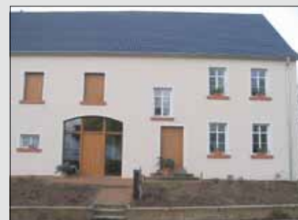
Sanierter Bauernhof als Niedrigenergiehaus Foto: VZ RLP/ Bernhard Andre
