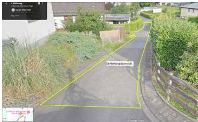
Abb. 3 - Garageneinfahrt - Hausnummer 30 Auf Höhe der Hausnummer 30 ist die Bordanlage im Einfahrtsbereich einer Garage abgesackt. Diese soll im Zuge der Maßnahme reguliert werden.
