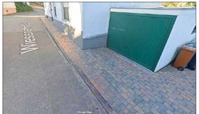
Abb. 3 - Garageneinfahrt - Hausnummer 30 Auf Höhe der Hausnummer 30 ist die Bordanlage im Einfahrtsbereich einer Garage abgesackt. Diese soll im Zuge der Maßnahme reguliert werden.
