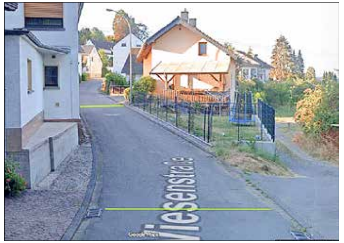
Abb. 2 Deckensanierung - ca 80m 2 Am Ende der Wiesenstraße sind Asphalt Versprödungen zu erkennen. In einem Bereich von ca 80m 2 soll nur die Asphaltdeckschicht abgefräst und erneuert werden.
