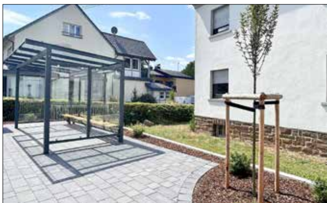
Die Fertigstellung der neuen Buswarte Halle in der Dorfmitte von Roßbach soll am 14. August 2026, 18.00 Uhr, ein wenig gefeiert werden.
