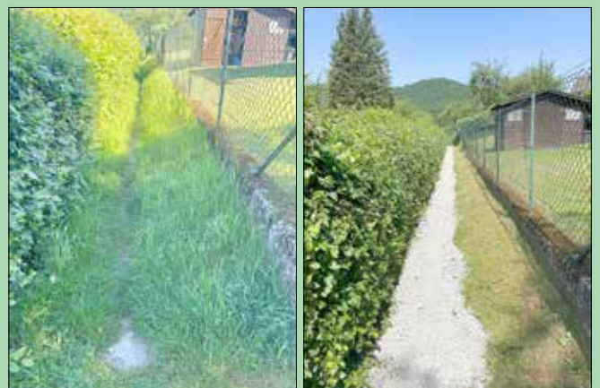
Vorher und nachher: der Verbindungsweg oberhalb des Alten Friedhofes. Der Weg wurde hergerichtet und ist nun mit Schotter befestigt.
